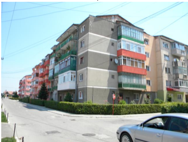
Blocuri de locuit de pe strada Cloșca
